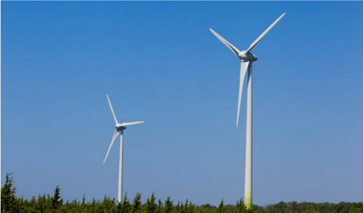
Foto 1.3.1.1 Kolmelabaline horisontaalteljega tuulik (allikas https://energiatalgud.ee/Elektrituulik#fn36 ).
